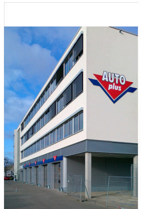
Bild rechts: Aufstockung Bürogebäude in Wolfsburg
