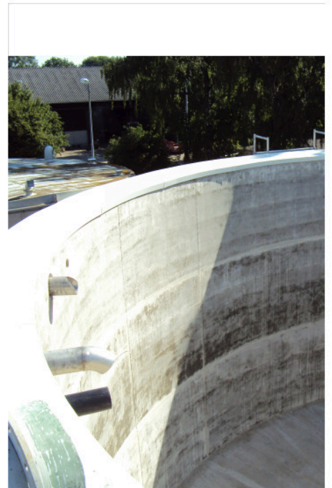
Bild rechts: neue Betoninnenschale
