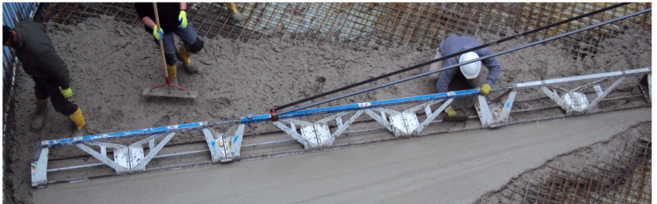
Bild unten: Betonierarbeiten am Behälterboden
